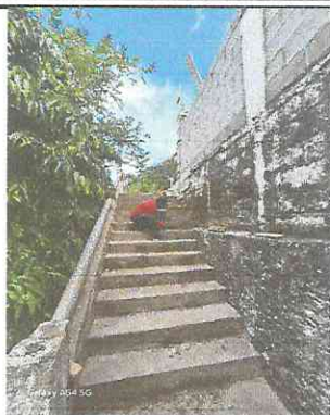
Reparación de gradas de la entrada principal de la escuela.
