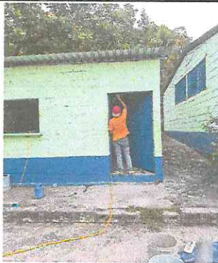
Sustitución de puerta de cocina.
