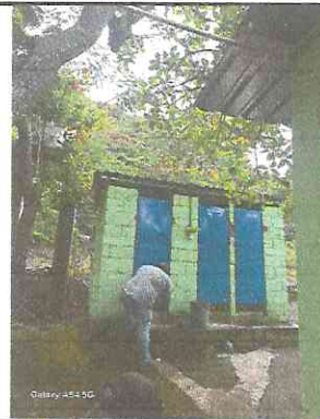
Sustitución de Puertas de baños.
