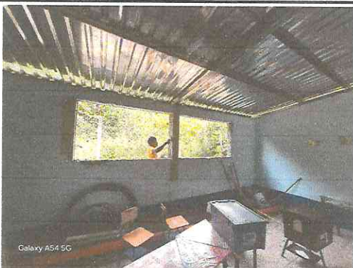
Suministro e instalación de ventanas PVC.
