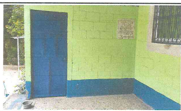
Suministro de instalación de puertas en aulas dirección y bodega.
