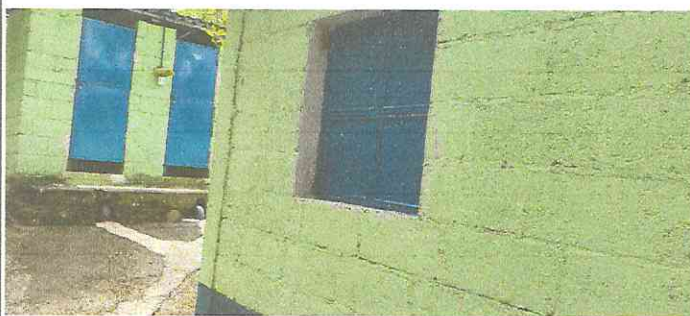
Matenimientos de ventanas de cocina.
