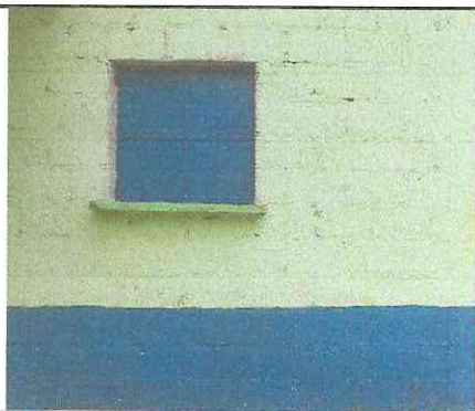
Matenimiento de ventanas de cocina.
