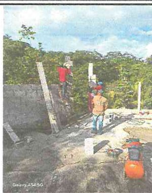
Suministro e instalación de portón de la entrada principal.
